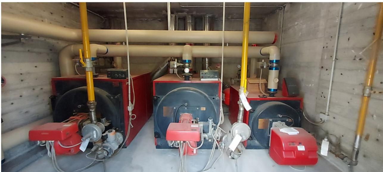
L'acqua calda prodotta in centrale termica viene convogliata mediante delle tubazioni interrato fino alla sottocentrale, dove si trovano i collettori dai quali si staccano i circuiti con le pompe per l'alimentazione agli impianti nelle varie zone.
